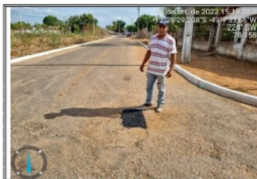
Foto 04 - Reparo da coleta da amostra rua T-3
